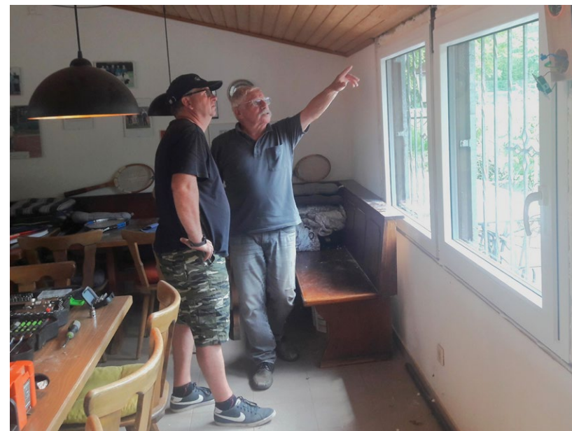
Erneuerung der Fenster im Tennisheim 2023
