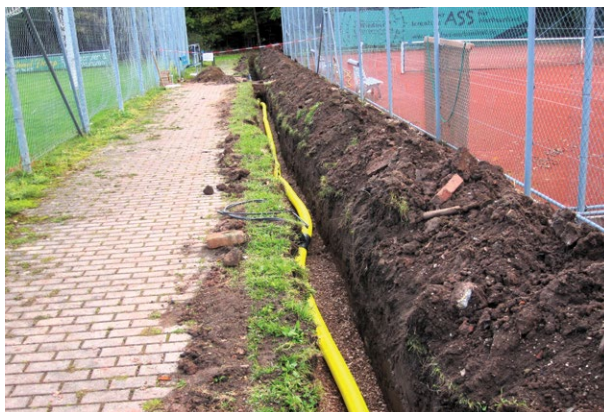
Einbau der Drainage neben Platz 3 und 4
