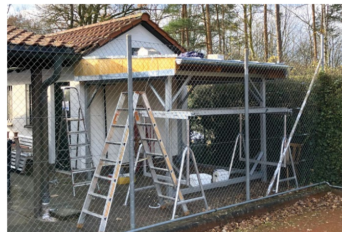
Installation des Geräte- anbaus vor Platz 1
