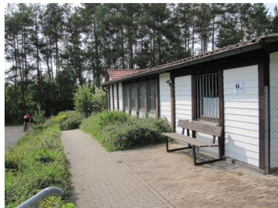
Die Südterrasse vor dem Umbau 2011
