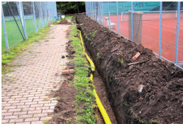
Einbau der Drainage neben Platz 3 und 4
