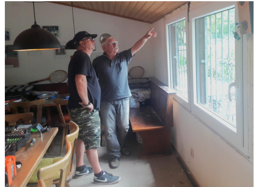
Erneuerung der Fenster im Tennisheim 2023
